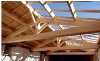
Pose de la charpente
