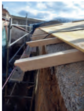
Pose de la charpente
