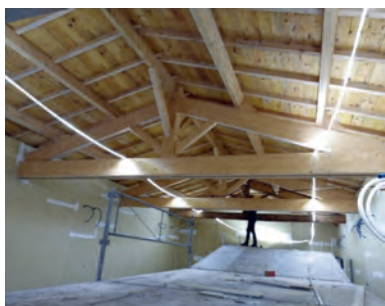
Pose du placo
